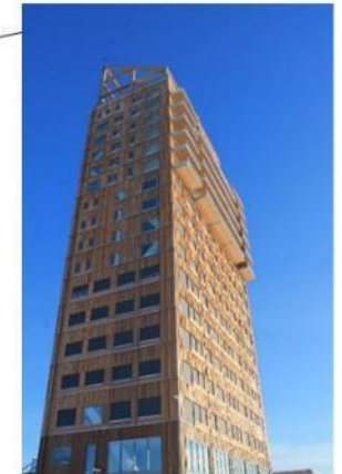
Mjøstårnet, 18 storeys, Glulam
